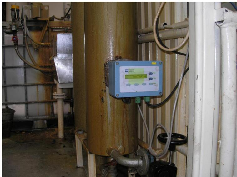
**Прибор НК6 должен быть установлен на вертикальной трубе (давление свыше 1,5 бар),**
