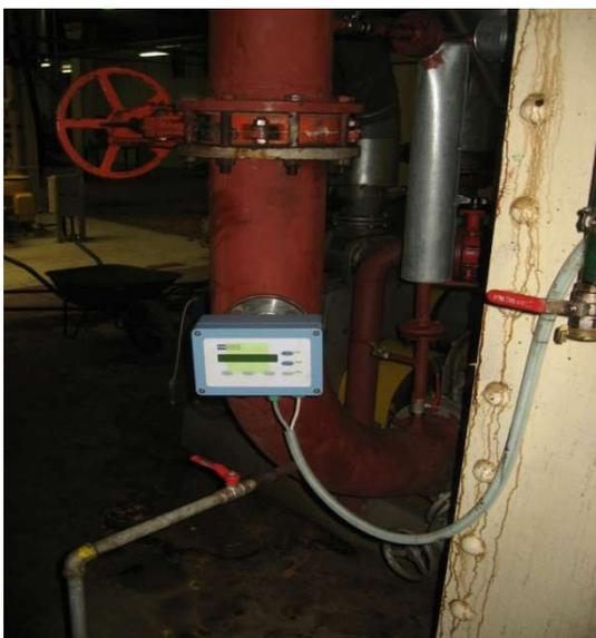
При установке на трубопровод монтируйте прибор таким образом, чтобы измеряемая среда протекала между антенн, а расстояние между колпачками антенн и стенкой трубы составляло не менее 50мм.
